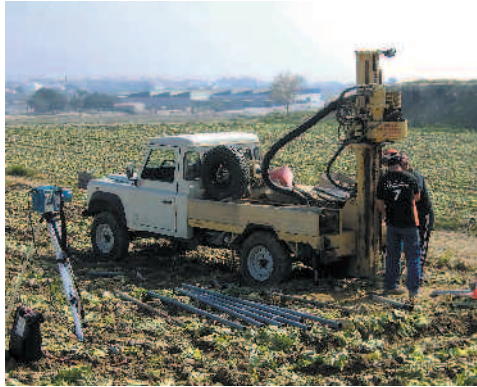
Ejecución de los sondeos y extracción de muestras.
